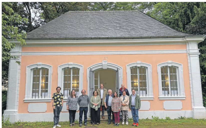
Schmuckstück. Stolz präsentieren die Mitglieder des Ortsbeirats Trier-Nord den frisch renovierten Pavillon im Park Nells Ländchen. Foto: Presseamt/jop
