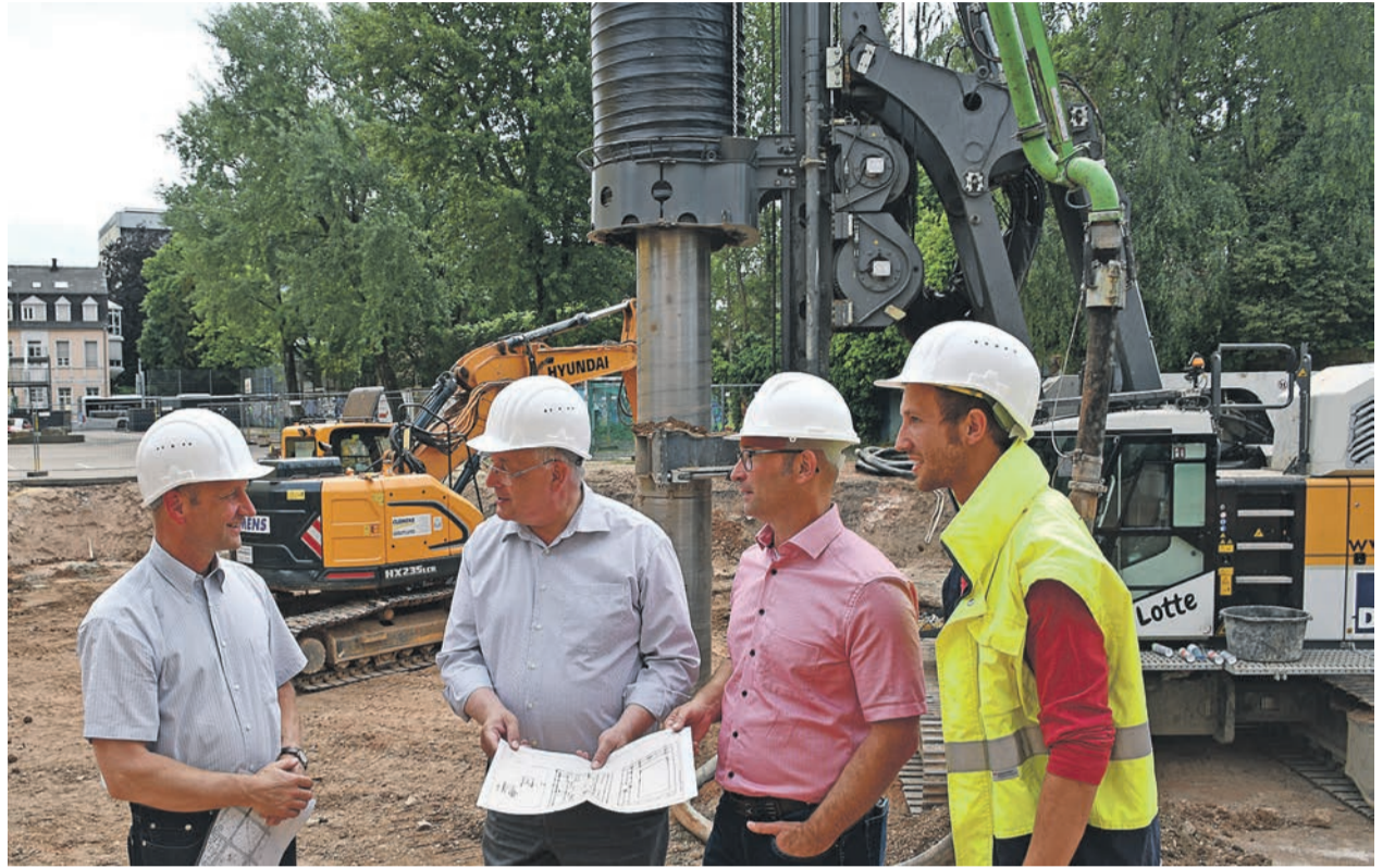
Sondierungsgespräch. Mit extraschwerem Gerät wird am HGT die Bohrpfähle zur Sicherung der Baugrube errichtet. Archäologe Joachim Hupe erläutert Baudezernent Andreas Ludwig, Schulleiter Carsten Stiller und Bauleiter Alexander Leidinger (v. l.) die Pläne für die anstehenden Ausgrabungen. Foto: Presseamt/kg
