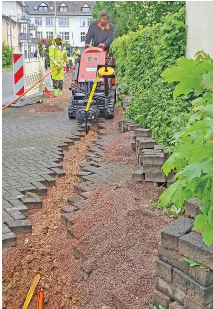
**Trasse.** Mit einem speziellen Vibrationsgerät zieht ein Bauarbeiter im Beutelweg die Kunststoffleitung durch die Baugrube, in der danach das Glasfaserkabel verlegt wird. Foto: Presseamt/pe
