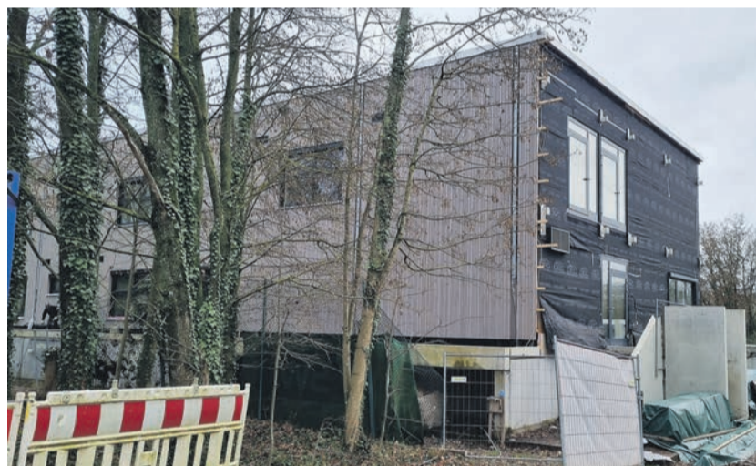
Zweiter Zugang. Der Blick von der Straße zeigt auch die Gebäudeseite der künftigen Kita, an deren Fassade (rechts) die Holzelemente noch angebracht werden. Dort wird Mitte Februar ein Laubengang montiert, der den vorgeschriebenen zweiten Zugang zum Gebäude sicherstellt.
