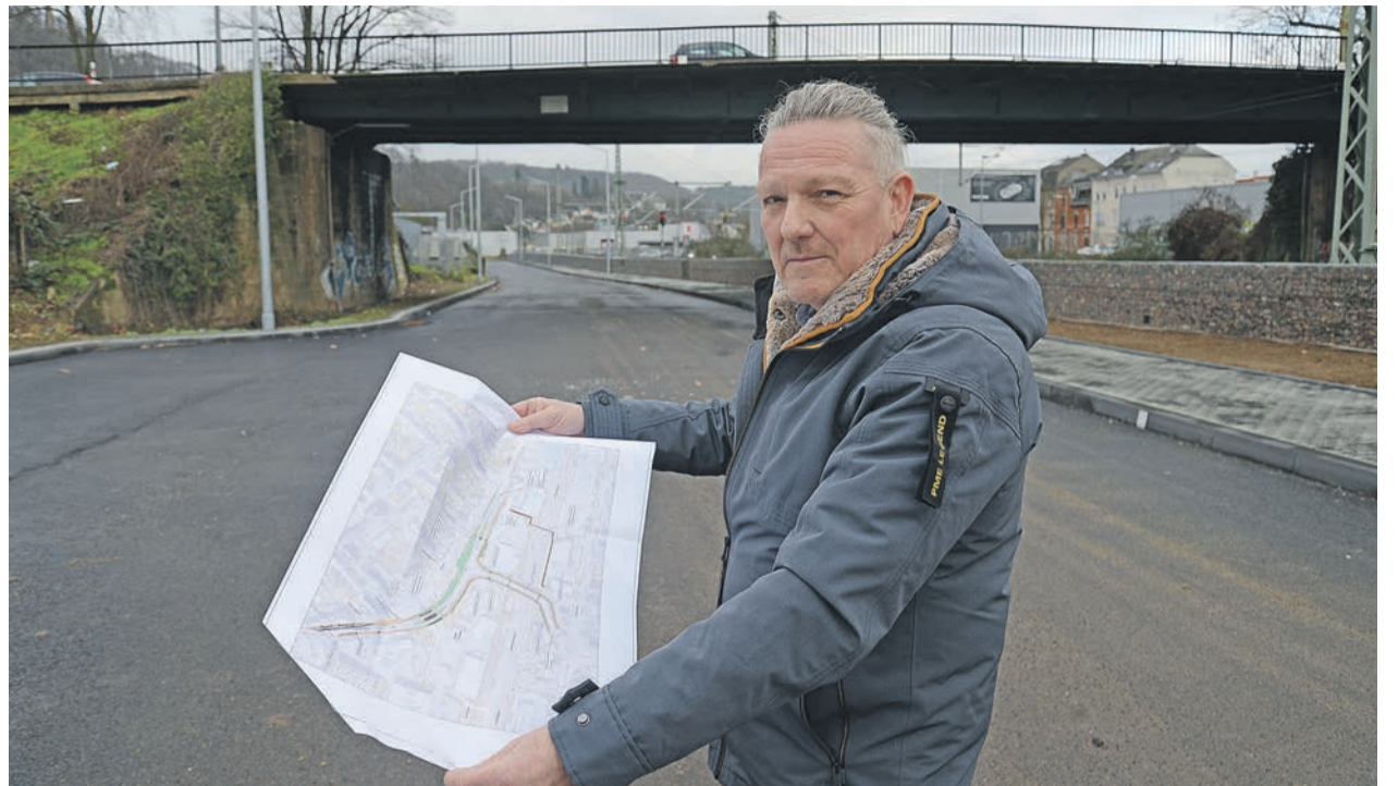
Heute und morgen. Bauleiter Thomas Adler vom StadtRaum Trier präsentiert die Planung für die baufällige Brücke in Trier-West, die neben der Eisenbahn-Weststrecke (rechts hinter der Mauer) auch die Fahrbahn der im Bau befindlichen Verbindungsstraße überspannt. Foto: Presseamt/kig
