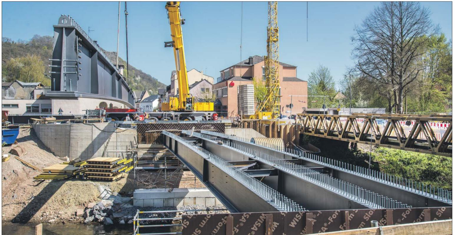
**Zentimeterarbeit.** In Maßarbeit setzt der Kranführer den 20 Tonnen schweren vierten Brückenträger auf den Auflager. 36 Meter lang ist jeder der insgesamt fünf Stahlträger. Nachdem diese miteinander verbunden sind, drückt das Gewicht von Stahlbetonplatten die Träger in ihre endgültige Position. Foto: jac
