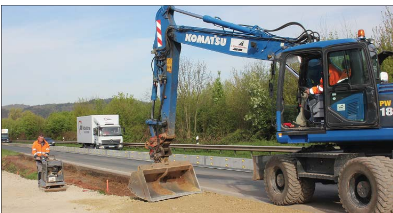
Vorarbeiten. Neben der gesperrten Autobahnspur laufen die Erdarbeiten für die Betonwand. Die Elemente sollen nächsten Montag geliefert werden. Foto: PA
