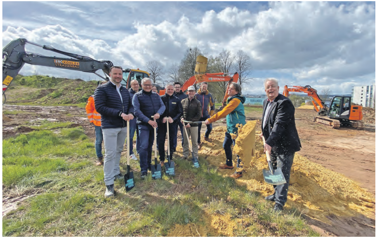
Baufläche. Baudezernent Andreas Ludwig und der Kürenzer Ortsvorsteher Ole Seidel (von rechts) freuen sich mit EGP-Geschäftsführer David Becker (links) und weiteren Beteiligten über den Start der Erschließung des Burgunderviertels in Neu-Kürenz. Foto: Presseamt/gut
