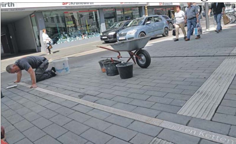
Kurz vor dem Start der Landesausstellung zum 200. Geburtstag von Karl Marx am 5. Mai ist die Fertigstellung des Platzes an der Kreuzung Jüdemer-, Brücken- und Karl-Marx-Straße zur Erinnerung an den Philosophen ein gutes Stück näher gerückt. Am Montag verlegten Arbeiter auf dem Boden die „Lebenslinien“ mit Zitaten und Lebensdaten von Karl Marx. Zu lesen ist etwa der Satz: „Das Volk, das ein anderes unterjocht, schmiedet seine eigenen Ketten.“ Foto: PA/gut
