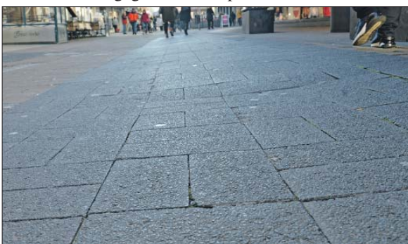
Stolperfallen. Unebenheiten und größere Fugen prägen das beschädigte Pflaster in der Fleischstraße, das ab 6. April durch einen Asphaltbelag ersetzt wird. Foto: PA/gut
