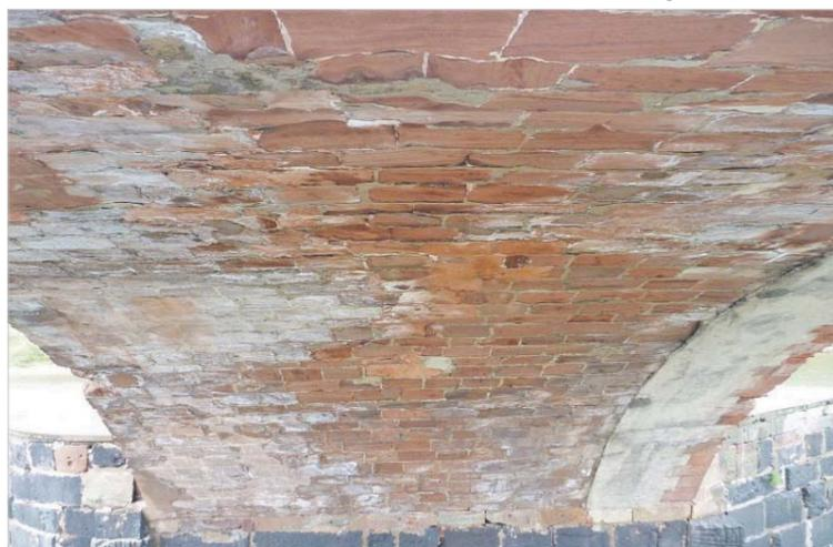
Angegriffen. Als „Aussinterung“ werden im Fachjargon diese durch Feuchtigkeit verursachten Schäden an der Unterseite eines Gewölbes der Römerbrücke bezeichnet. Foto: TBA
