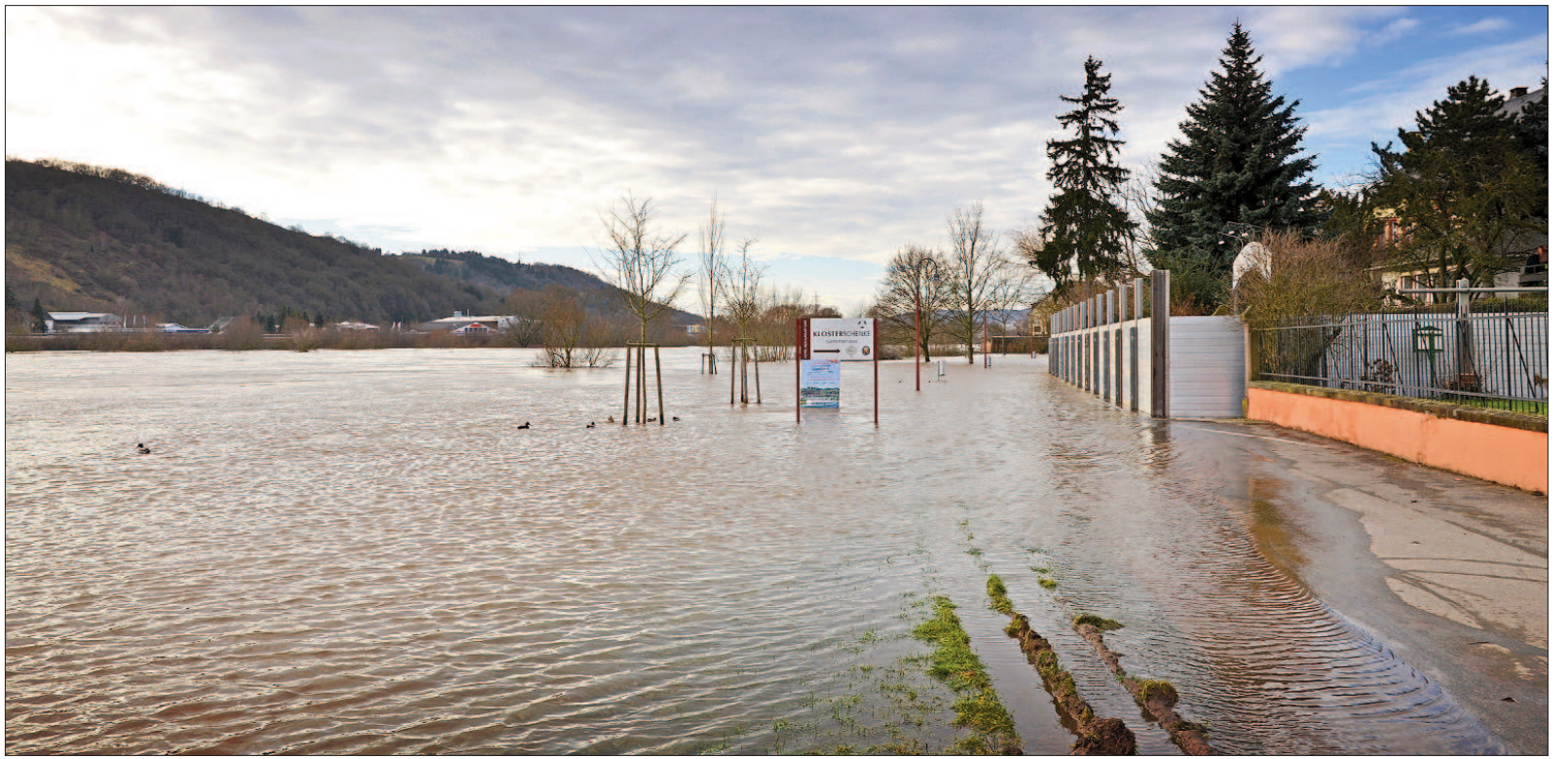
Land unter. Im Vergleich zur Katastrophe von 1993 verlief das Moselhochwasser vom Januar 2011 mit einem Scheitelpunkt von 8,70 Meter glimpflich. Durch die jetzt gegründete interkommunale Hochwasserpartnerschaft sollen Vorsorgemaßnahmen, wie sie im Stadtteil Pfalz mit der mobilen Schutzmauer (Foto) bereits umgesetzt wurden, optimiert werden. Foto: PA/Archiv
