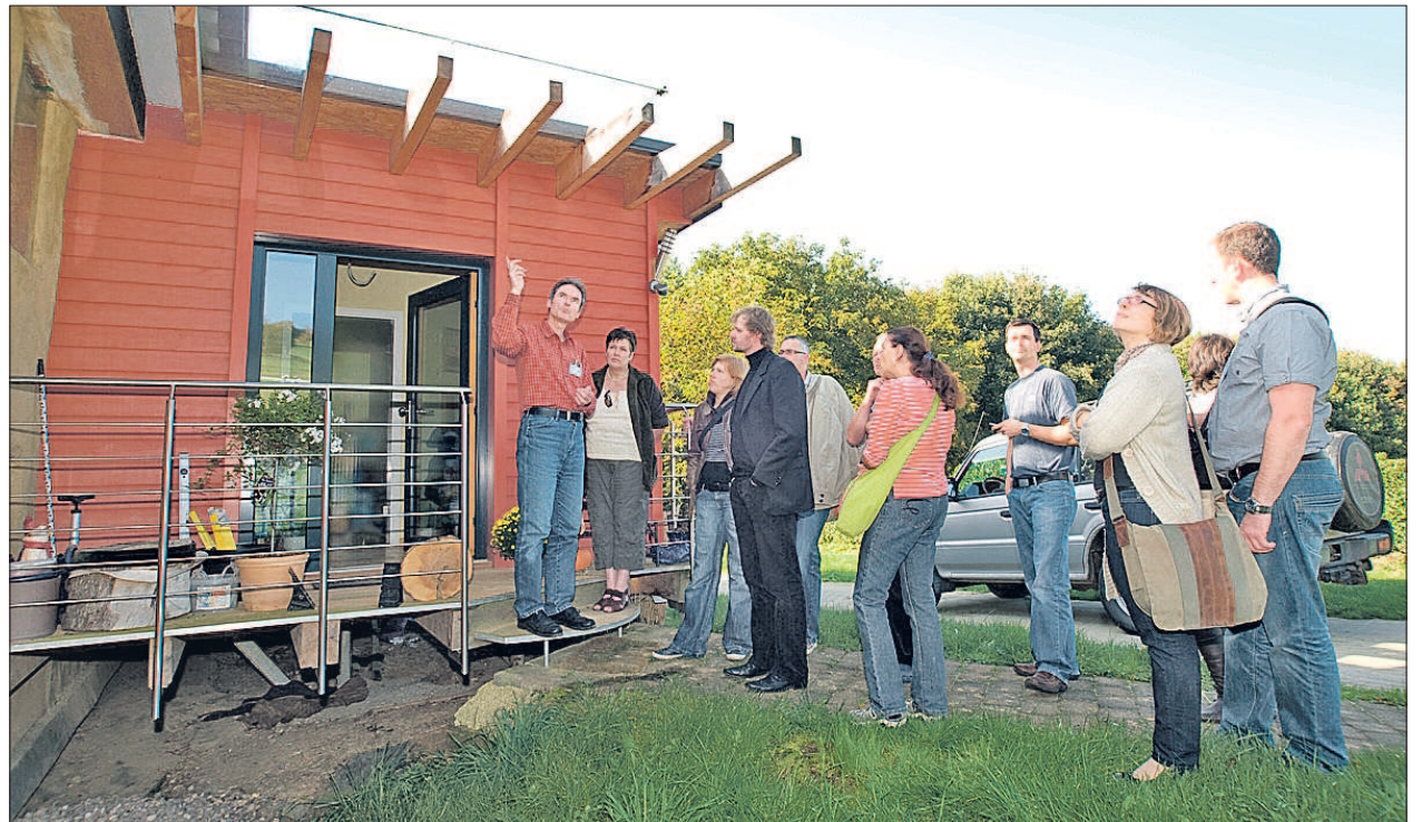
Strohhaus. Die Energietouren machten bereits mehrfach Station in einem Haus in Irsch, das aus Strohballen errichtet und mit Lehm verputzt wurde. Umweltberater Johannes Hill (l.) stellte einer Gruppe im Herbst das Gebäude vor, dessen Eingang aus rot angestrichenen Holzelementen besteht. Foto: Solarverein
