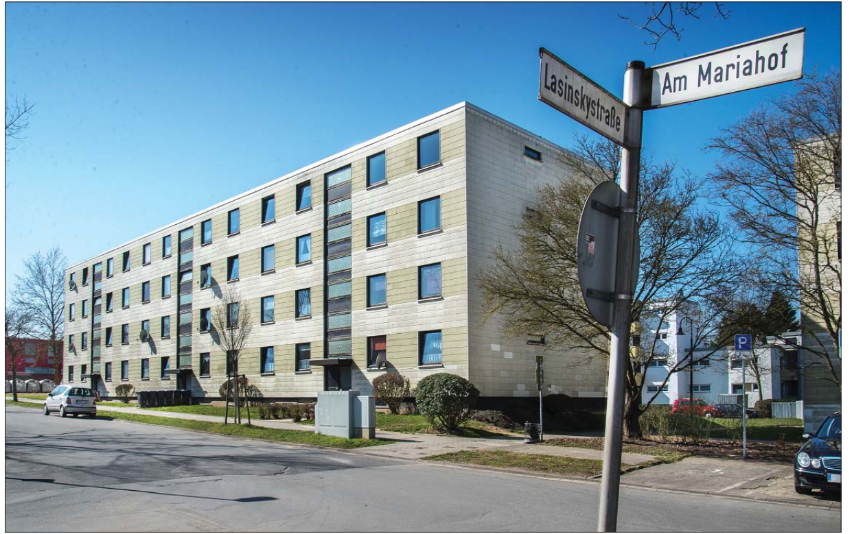
Fassade. Blick auf einen der insgesamt sechs städtischen Wohnblocks auf Mariahof, die zur Sanierung anstehen. Das Gebäude mit insgesamt 24 Wohnungen wurde Mitte der 60er Jahre errichtet. Foto: Presseamt
