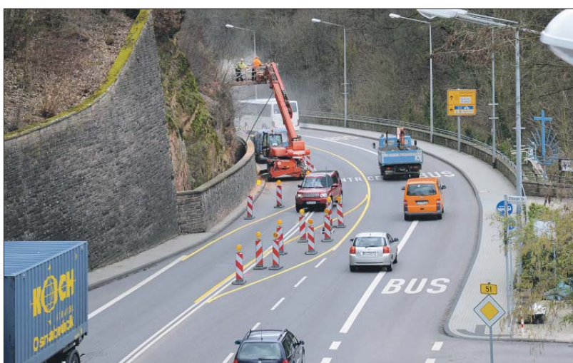
Spurwechsel. Aktuell werden in den Fels drei Meter lange Nägel eingebracht, an denen das Netz zur Felssicherung dann befestigt wird. Foto: Presseamt
