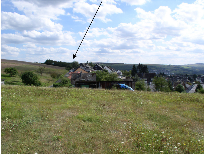
Blick von Standort Ta-W-02 nach Süden auf den Ortsrandbereich mit der Fläche Ta-W-01.
