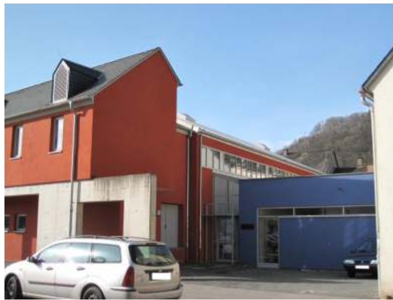
Trier-Ehrang: Neubau Bürgerhaus
