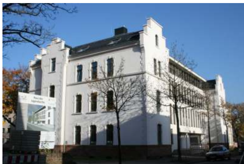
Trier-West: Sanierung/Neubau „Haus des Jugendrechts“
