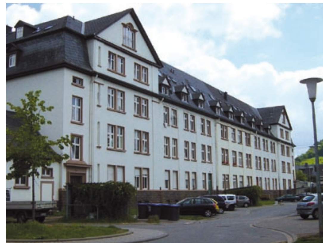
Typische Gebäudestruktur: Ehemaliges Kasernengebäude Am Beutelweg 14-20
