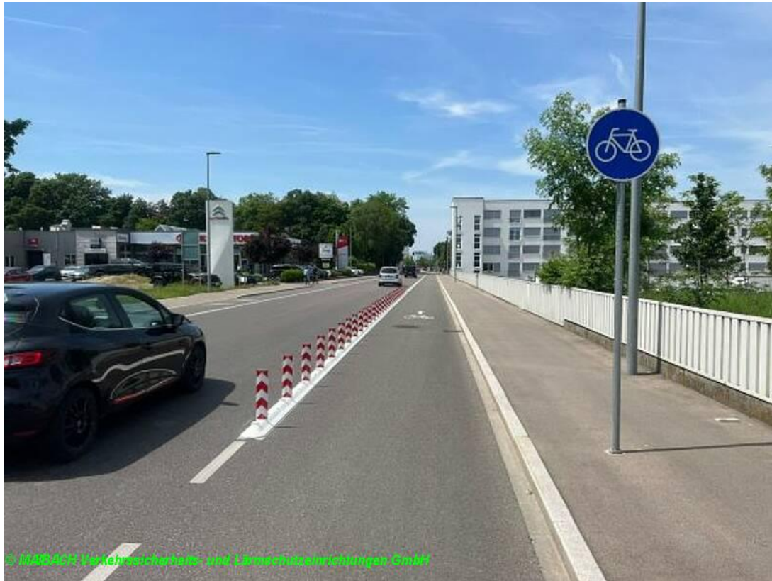
Abbildung 4: Leitschwellen mit Leitfahne [Quelle: https://www.maibach.com/ ]
