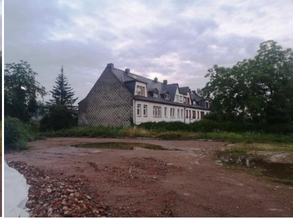
Abbildung 7: Reihenendhaus und Gehölzstrukturen im Bereich der Gleisbrachen im Nordosten des UG
