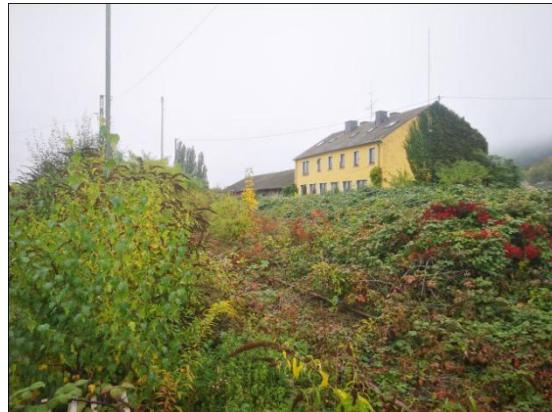
Abbildung 9: verbuschte Gleisbrache und Bestandsgebäude
