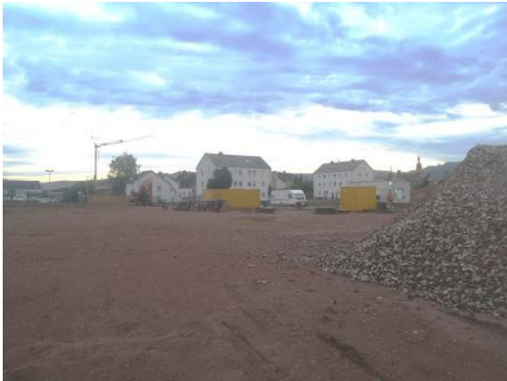
Abbildung 4: Freifläche mit Schutthalden und angrenzenden Bestandsgebäuden im Westen
