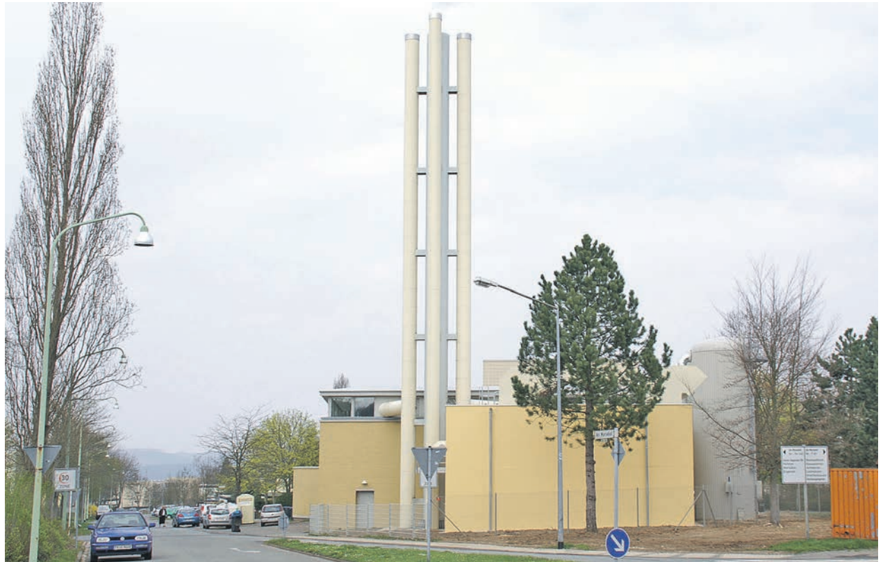
Zentralheizung. Das 1963 errichtete und 2005 modernisierte Heizkraftwerk der Stadtwerke in Mariahof ist ein bewährtes Beispiel für die Nahwärmeversorgung eines ganzen Stadtteils. Foto: SWT
