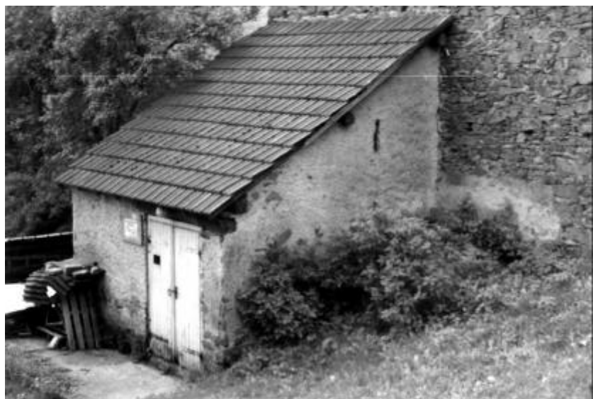
Abb. 7 Ehemaliges Feuerwehrhaus in der Franzenheimer Straße
