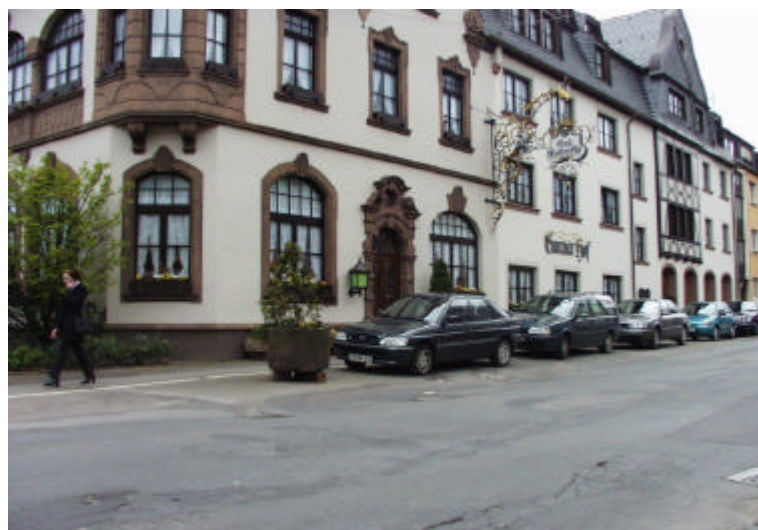
Abb.5: Eingangsbereich „Hotel Eurener Hof“
