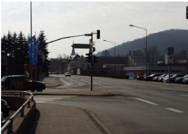
Abb. 18: Eurerer Straße (Ortseingang, Bereich Sportanlage)
