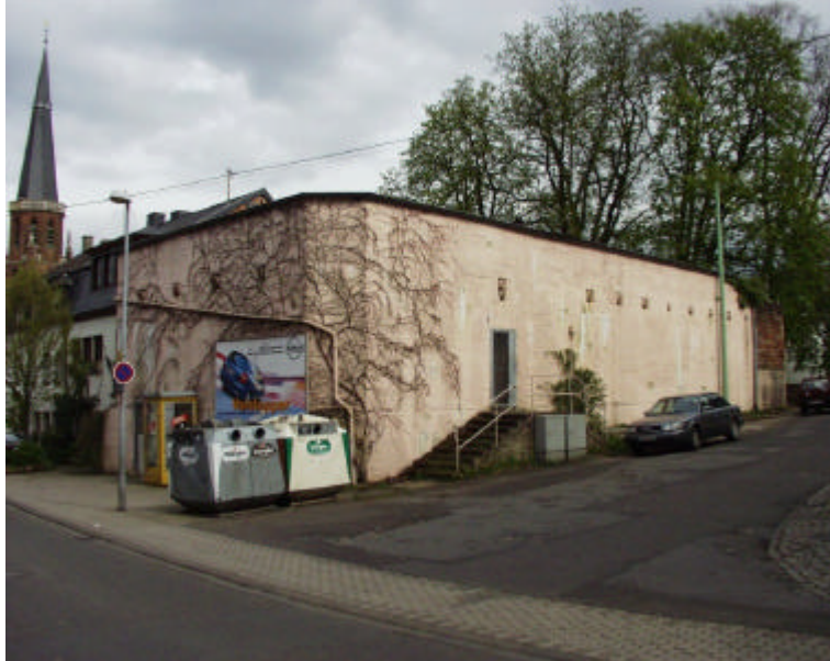
Abb.15: Bunker in der St.-Helena-Straße
