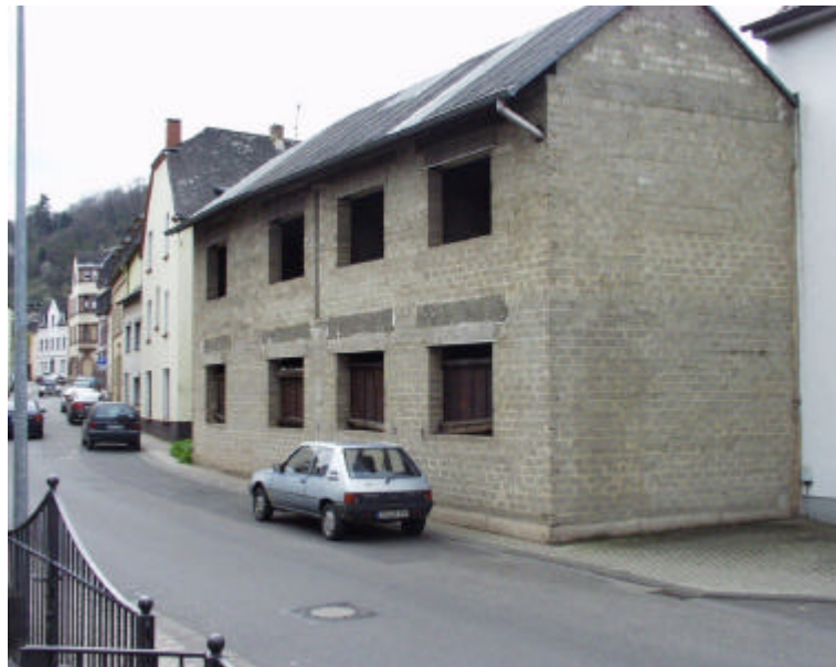
Abb.14: Baustelle gegenüber der Kirche.
