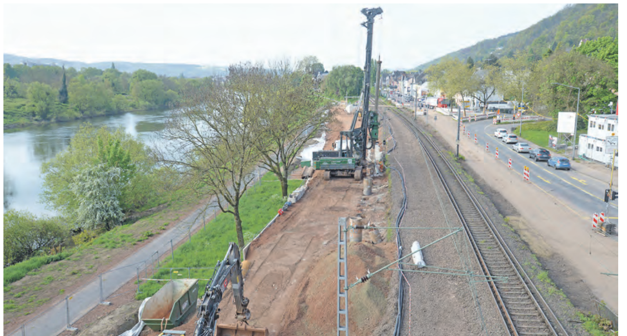
Schwer was los. Mit einem Pfahlbohrgerät werden am künftigen Haltepunkt Pallien die Tiefgründungen für einen der 170 Meter langen Bahnsteige verankert. Links verläuft die provisorische Trasse des Moselradwegs. Foto: PA/ig
