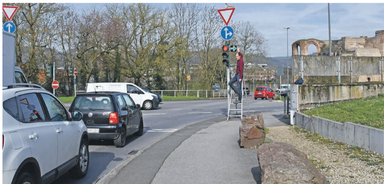
Umstellung. Baudezernent Dr. Thilo Becker präsentiert den neuen Grünen Pfeil an der vielbefahrenen Kreuzung am Alleenring. Foto: Presseamt/bau
