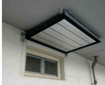
druckdichtes Klappschott
