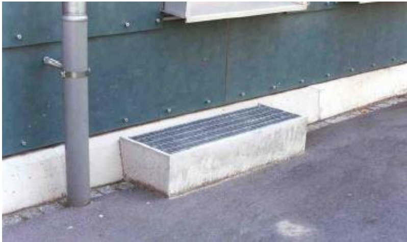
Höhergelegter Luftschacht (Amt für Appenzell Ausserrhoden 2006)
