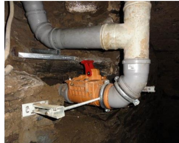
Rückstauklappe (Heisler 2011)
