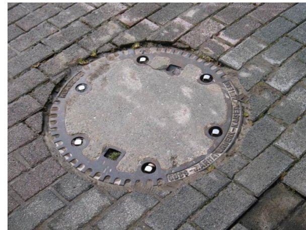
Verschraubter Kanaldeckel (Gretzschel 2010)
