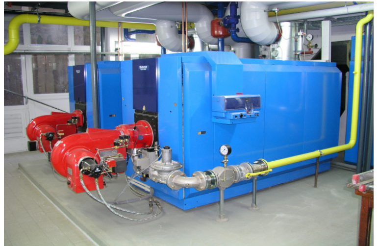
Abbildung: Sanierte Heizzentrale BBS G+T
