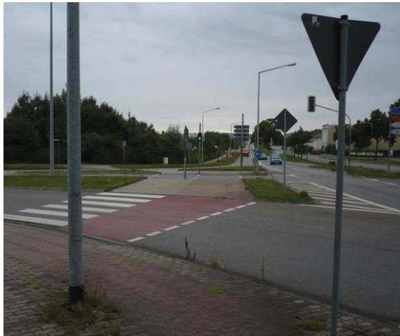
**Abbildung 41: Führung an freiem Kfz-Rechtsabbieger (außerorts); hier: Zufahrt K.-Adenauer-Brücke**
