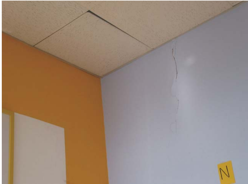
Abb. 27: mangelhafte Befestigung der Deckenplatten
