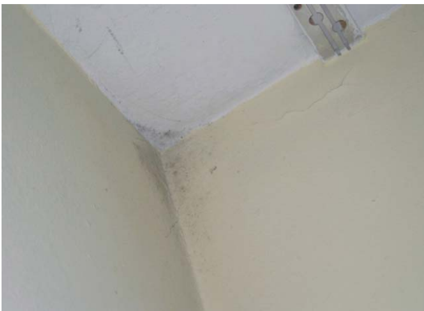
Abb. 26: Schimmelbildung in oberer Zimmerecke
