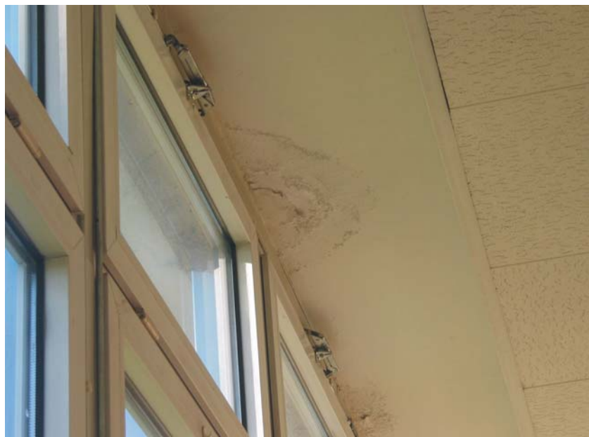
Abb. 24: Putzschäden durch starke Durchfeuchtungen
