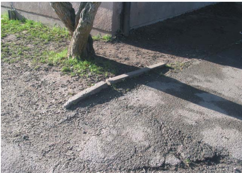
Abb.19-20: Lose T-Steine, Randsteine und Asphaltbeläge, bedingt durch Wurzelhub der Bäume. Unfallgefahr! (Fotos; A. Christmann)
