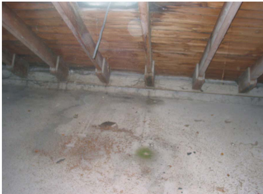
Abb. 28: Durchfeuchtung und Moosbildung auf dem Boden
