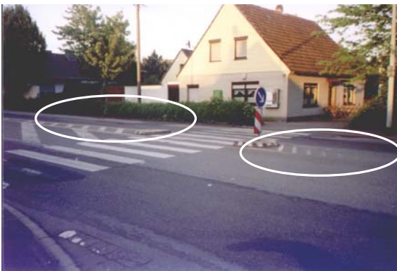
Abb.43: Einmündung der Franz-Buß-Straße in die Straßburger Allee (linke Seite)
