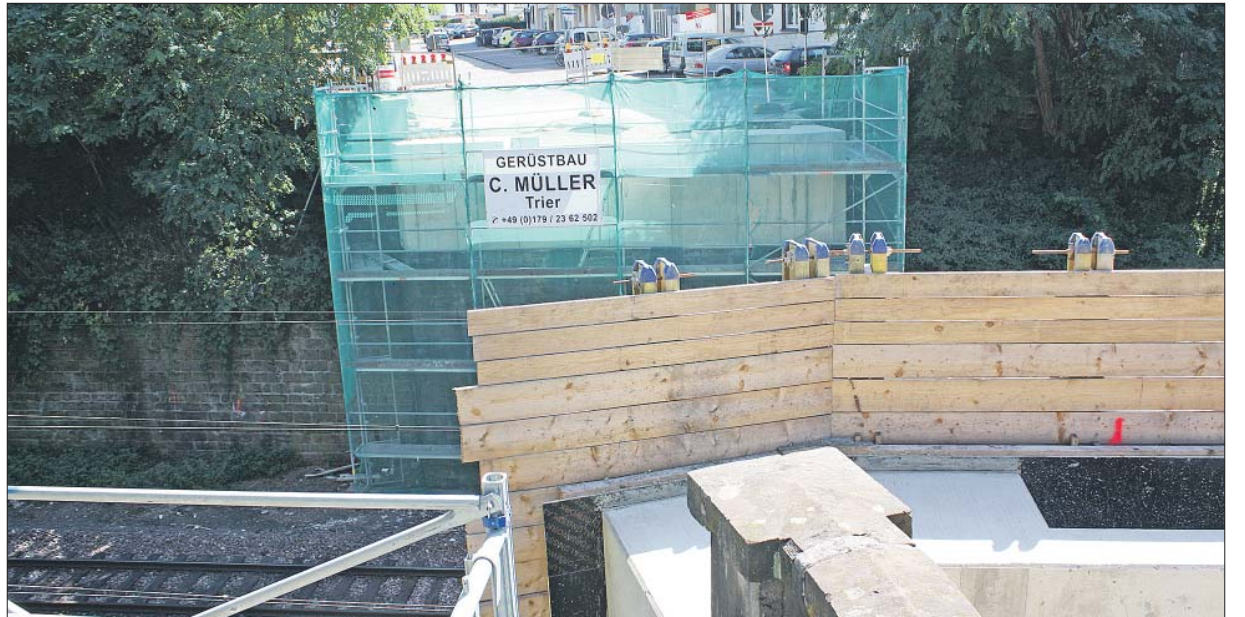
Lückenschluss. In der Hermesstraße im Gartenfeld wird Ende dieser Woche die neue Eisenbahnüberführung für Fußgänger und Radfahrer eingebaut. Der Erhalt dieser Verbindung in die City nach dem Abriss der maroden Vorgängerbrücke war ein wichtiges Anliegen im Bürgerhaushalt 2015/16. Foto: Presseamt
