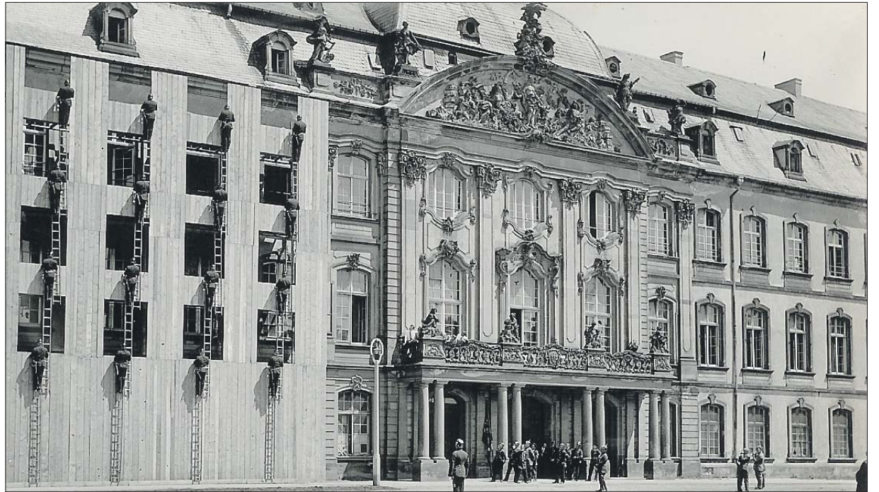
Trainingskulisse. Im Juni 1931 stellten Einsatzkräfte bei der 34. Tagung des Feuerwehrverbands der Rheinprovinz ihr Können vor der spektakulären Kulisse des Kurfürstlichen Palais unter Beweis. Dafür wurde eigens eine Übungsfassade zum Klettern (links im Bild) errichtet. Foto: Feuerwehrarchiv/F. Jdzior
