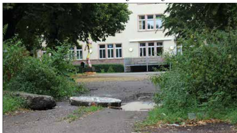
Hindernisse. Nicht nur dieses Schlagloch macht den Weg vom Parkplatz zum Bürgerhaus Trier-Nord derzeit noch zu einem Hindernislauf. Foto: PA
