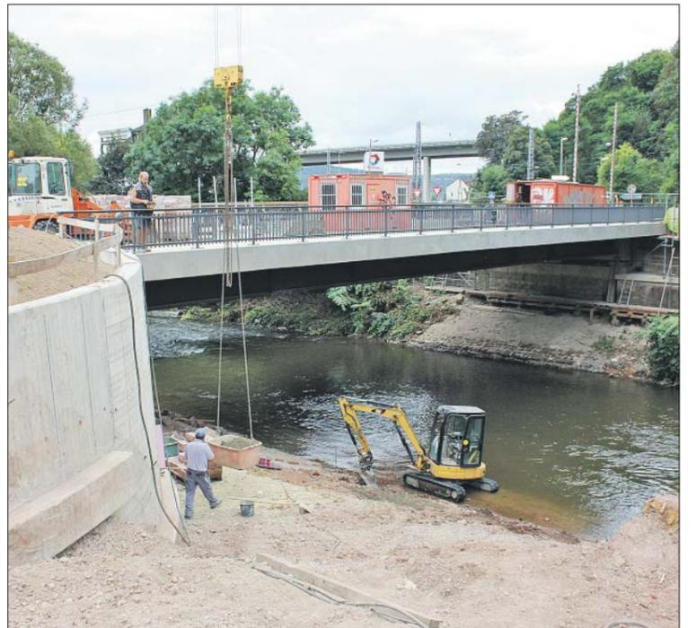
**Überspannt.** Blick auf die neue Brücke über die Kyll aus Richtung Norden. Die Stützmauer im Vordergrund wird mit Sandsteinblöcken verkleidet. Foto: PA
