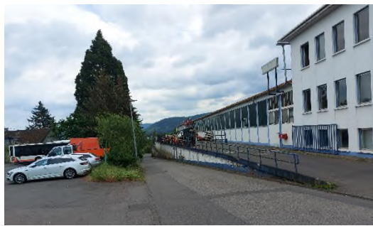
Parkplatz Aldi, Gewerbenutzung
