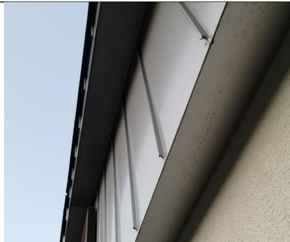
Abbildung 30: dicht verschlossene Dachrandverblendung
