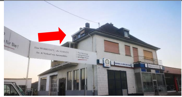
Abbildung 33: Quartierpotential am Dachbereich des Wohnhauses
