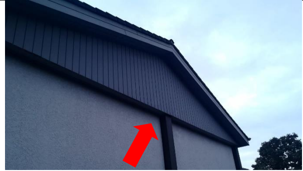
Abbildung 27: Giebel Ostseite mit potentiellen Quartieröffnungen (rote Pfeile)
