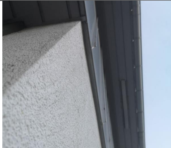
Abbildung 28: dicht verschlossene Dachrandverblendung
