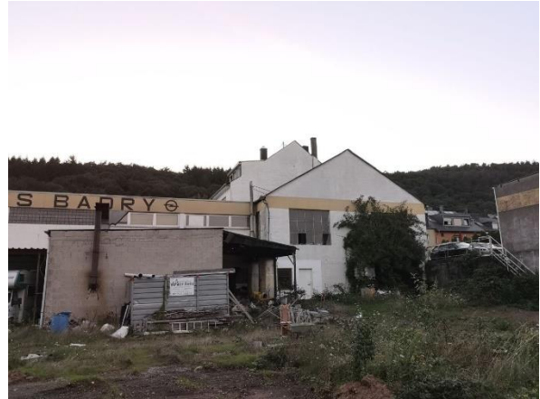
Abbildung 16: Rückseite Autowerkstatt mit angegliedertem Wohnhaus
