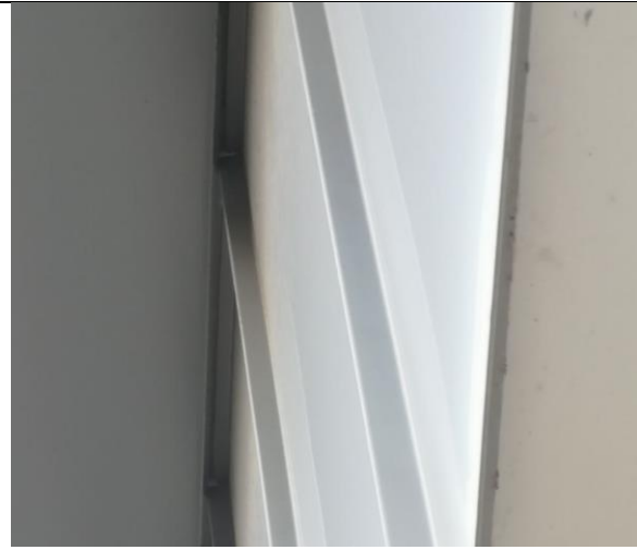
Abbildung 29: dicht verschlossene Dachrandverblendung
