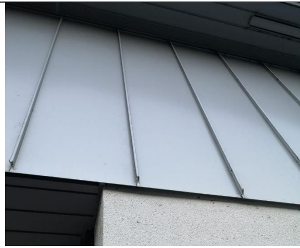
Abbildung 31: dicht verschlossene Dachrandverblendung
