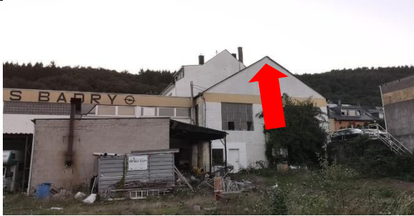
Abbildung 34: potentielle Quartieröffnung auf der Rückseite des Wohnhauses
