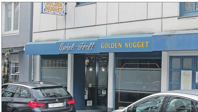
Eingänge. Diese Spielhallen in der Brotstraße (oben) und Brückenstraße genießen weiter Bestandsschutz. Für Neuansiedlungen an diesen Standorten gelten künftig jedoch Einschränkungen. Fotos: Presseamt
