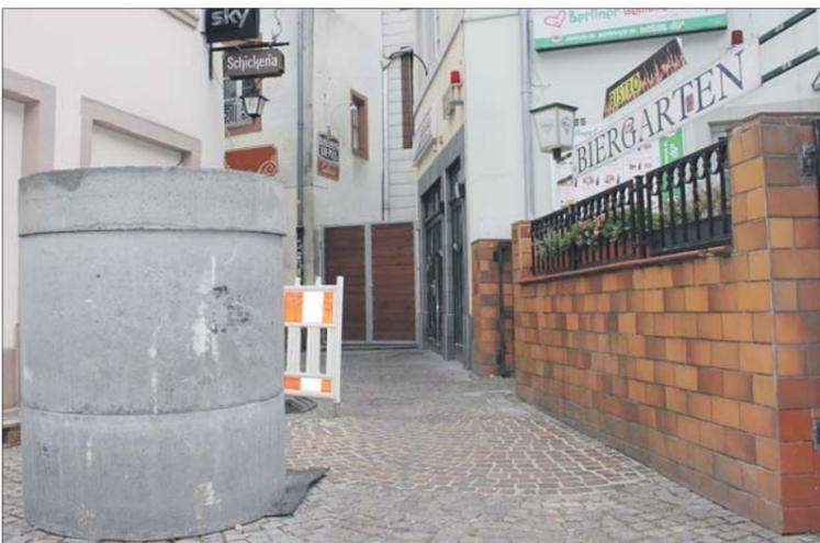
**Absicherung.** Ein Betonelement steht bereits in der Judengasse. Eine schwarze Bodenmatte verhindert das Verrutschen. Als weiteres Schutzelement wird am obersten Ring noch ein reflektierender Streifen angebracht, damit Radfahrer und Fußgänger im Dunkeln die Barriere rechtzeitig sehen. Foto: Presseamt
