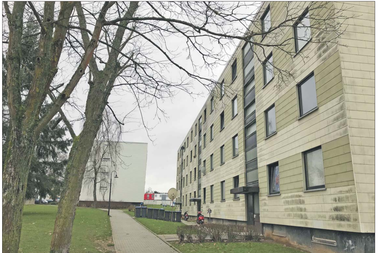
Alt und neu. Die städtischen Wohnblocks auf Mariahof sind – deutlich sichtbar – stark sanierungsbedürftig. Im Hintergrund sieht man eines der bereits an Fassade und Fenstern sanierten Gebäude. Foto: PA/mic
