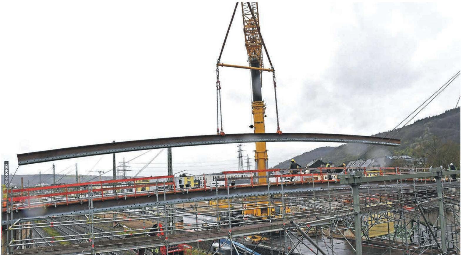
**Imposant.** 36 Tonnen hängen an: Ein weiteres gewölbtes Stahlträgererelement für den Überbau der Eisenbahnüberführung in Trier-West wird vom Schwerlastkran eingehoben. Foto: Presseamt/kg
