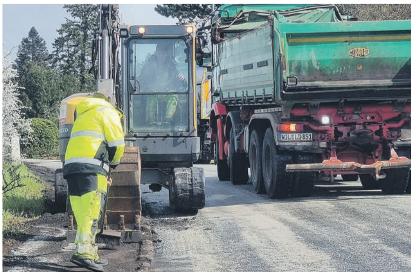
Endspurt. Nachdem die Arbeiten auf den verschiedenen Fahrbahnabschnitten abgeschlossen waren, setzten die Mitarbeiter der Firma Lehnen Donnerstagmorgen noch den Gehweg unterhalb des Hotels Petrisberg instand. Foto: PA/pe
