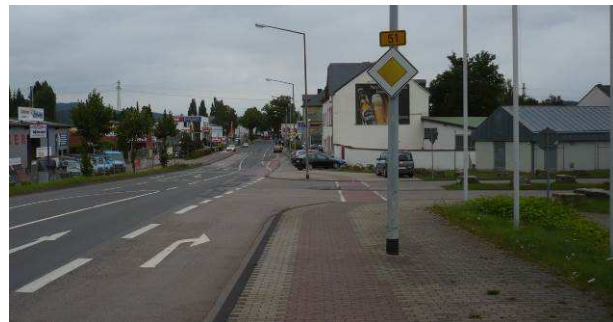
Abbildung 31: Luxemburger Straße / Lambertstraße – unzureichende Einbindung Rf
