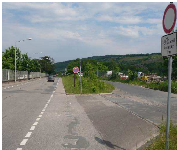
Abbildung 35: Schutzstreifen ohne innere Leitmarkierung; hier: Metternichstraße
