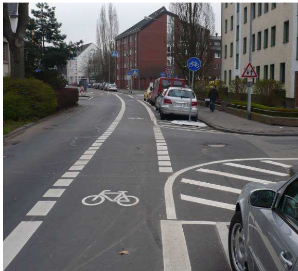
Abbildung 33: Markierung im Zuge von Radfahrstreifen; hier: Hohenzollernstraße
