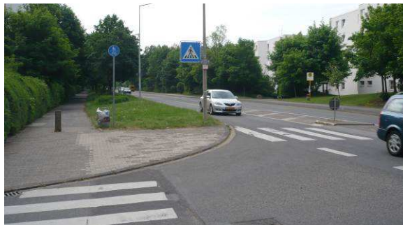
Abbildung 30: Kohlenstraße / Am Weidengraben – fehlende Einbindung Rf
