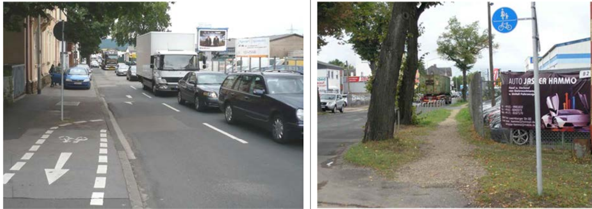
Abbildung 19: Fehlende oder mangelhafte Radverkehrsanlagen; hier: Luxemburger Straße
